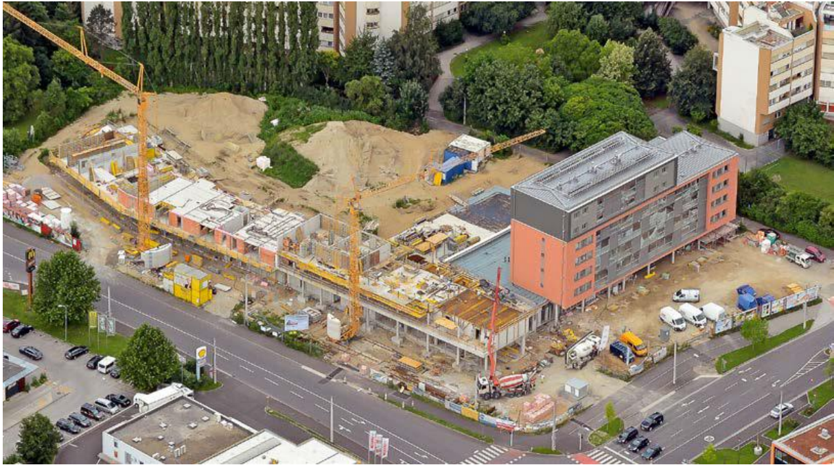
Die Baustellen der Wohnanlagen auf dem Preining-Grundstück und auf den ehemaligen Färberböck-Gründen. (Foto: STPL/PH)
